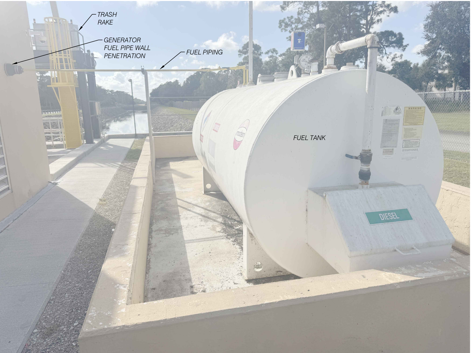
3 SITE PHOTO P4-C3 NTS
