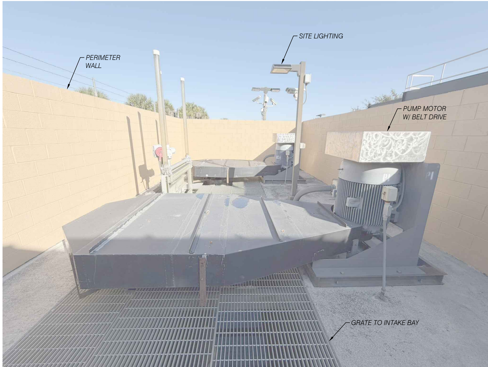
3 SITE PHOTO P9-C3 NTS
