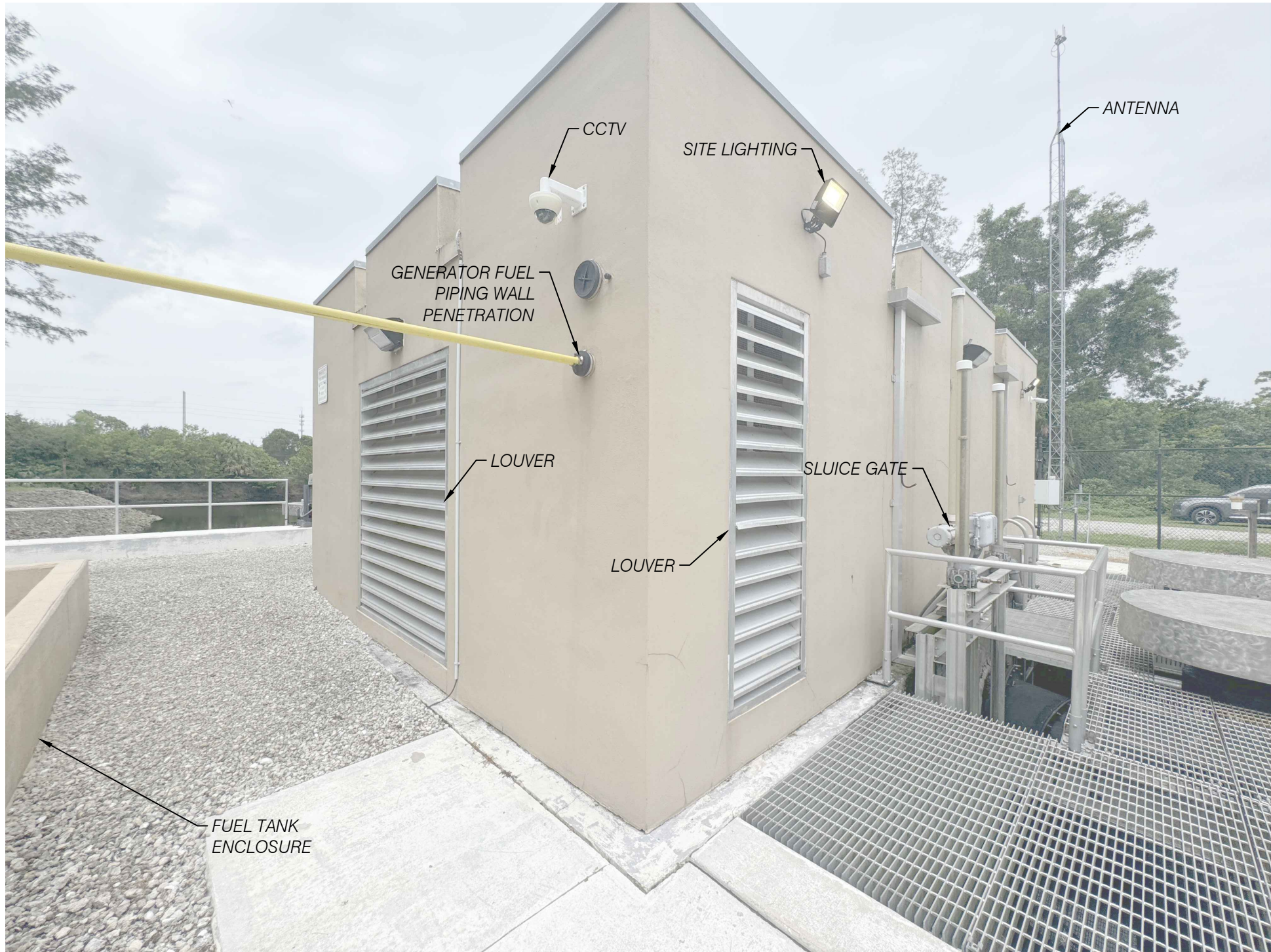
2 SITE PHOTO P3-C3 NTS
