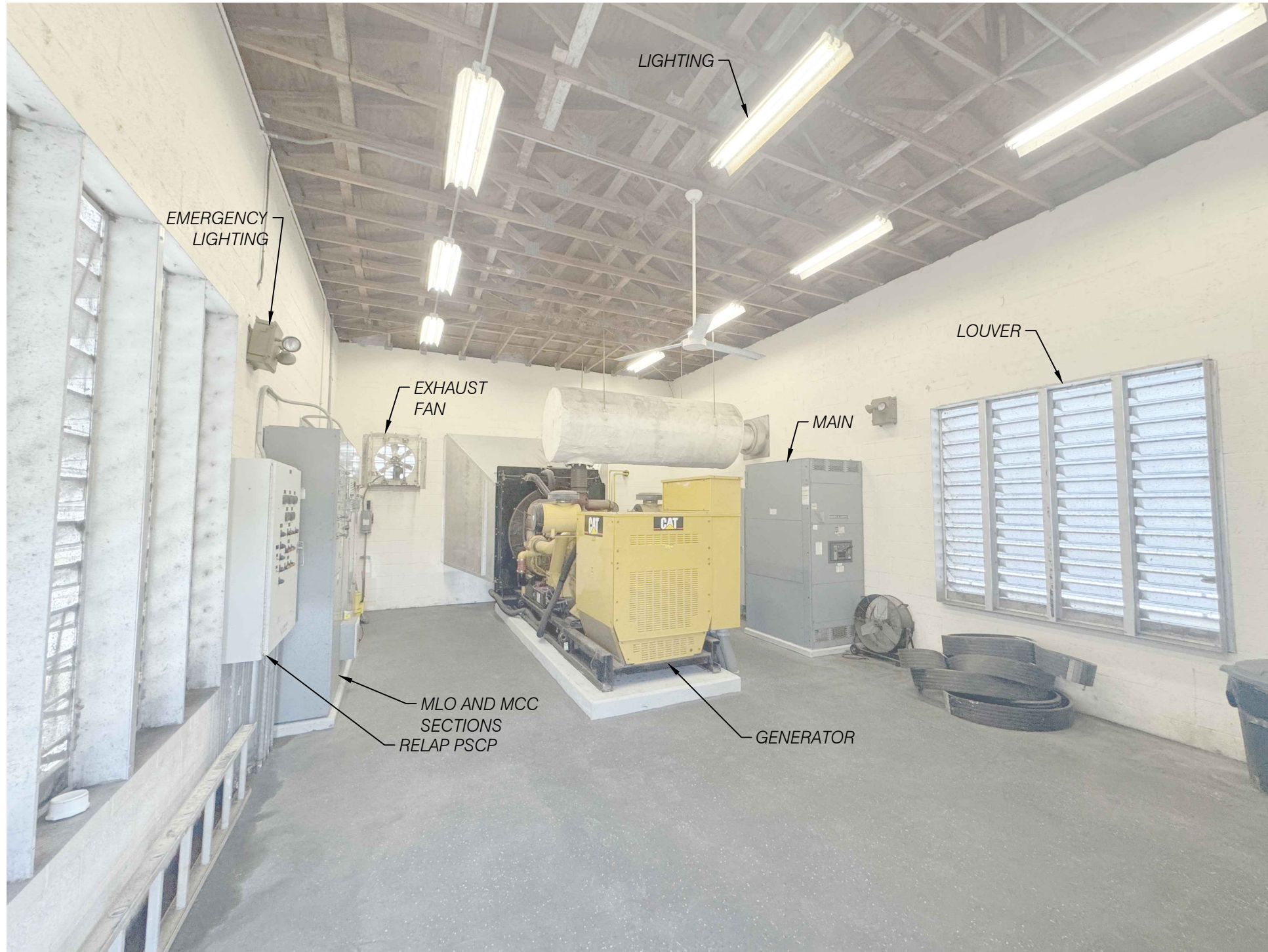
3 SITE PHOTO P7-C3 NTS
