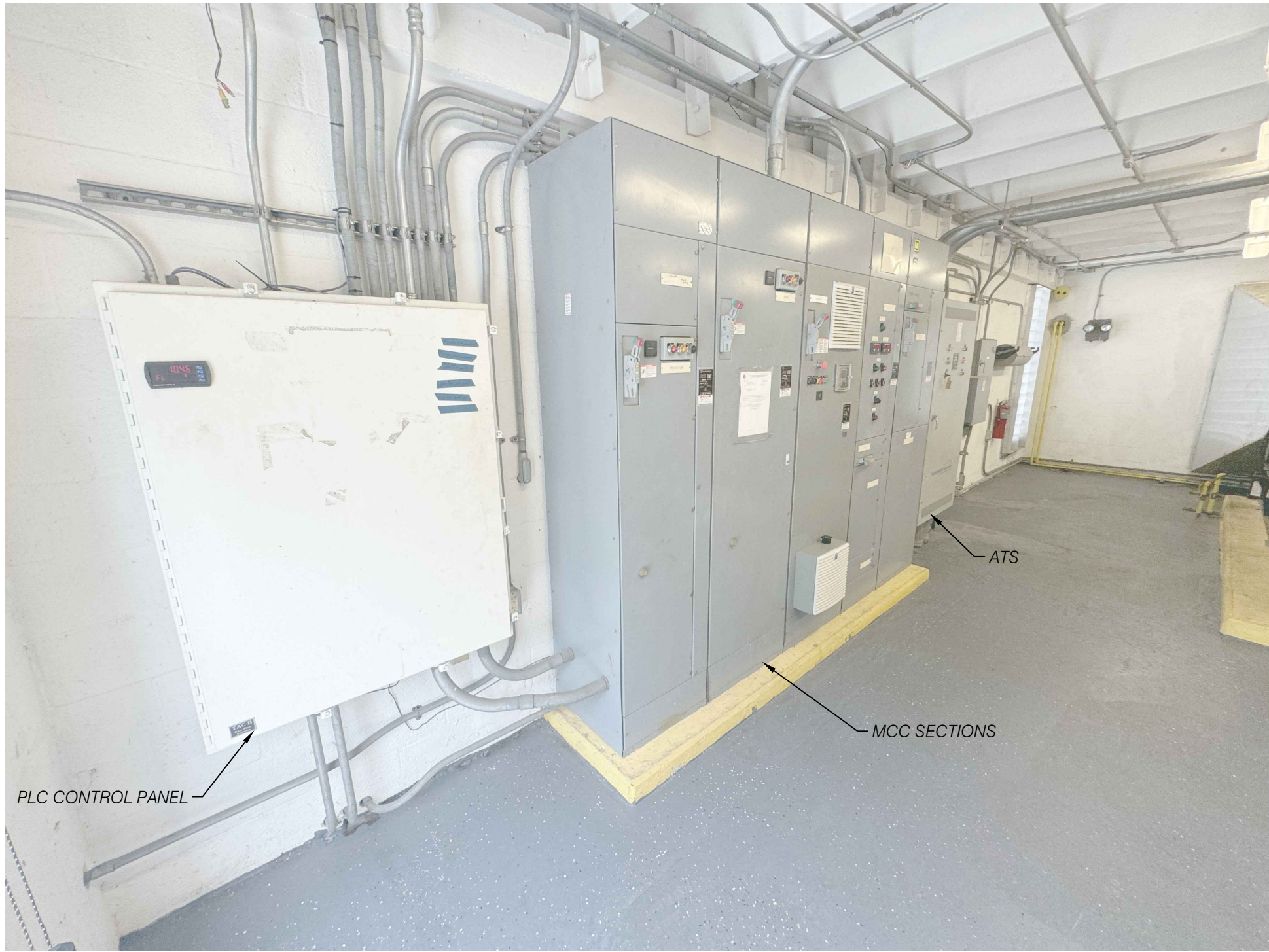
5 SITE PHOTO P3-C3 NTS
