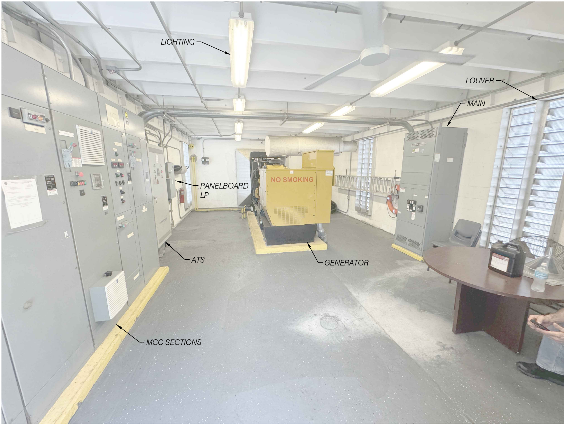
4 SITE PHOTO P3-C3 NTS
